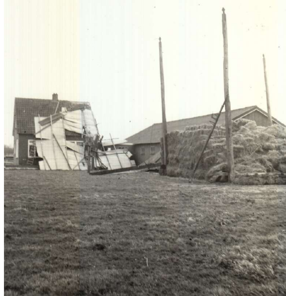
Fig. 125. Op 23 februari 1967 blies een storm de kap van de hooiberg op de nieuwe boerderij van de familie Moed aan de Wolfshagenweg. (collectie Moed).
