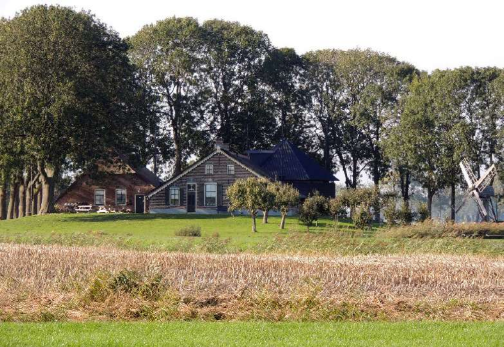
Fig. 81. De museumboerderij van Erf 29 geeft een mooie indruk van de zogenaamde 'hallehuisboerderij'. Dit type boerderij had een lengte van 30 meter, een breedte van 12 meter en was vooral opvallend laag gebouwd zodat de behuizing zo weinig mogelijk wind ving in het altijd winderige open polderlandschap. Het dak was met riet bedekt dat lokaal werd gesneden uit de uitgestrekte rietvelden zoals je die bijvoorbeeld in het begin van de 19 de eeuw nog terug kon vinden langs de noordgrens van de Mandjeswaard. Een dikke honderd jaar terug bepaalden deze typische boerderijen het beeld op bijna iedere belt. Foto: Jeroen Wiersma.
