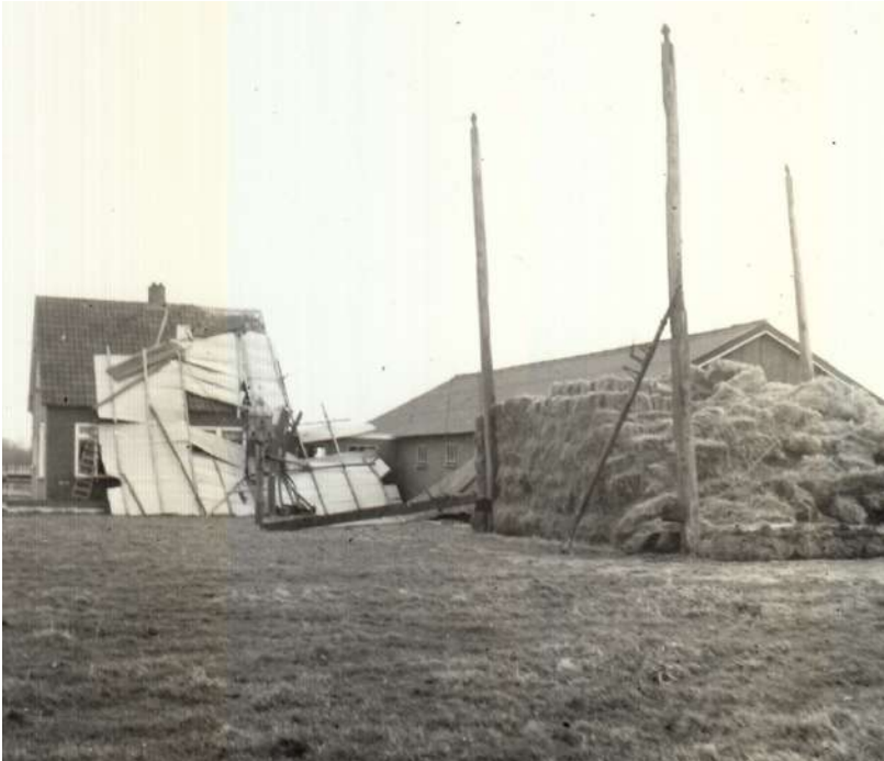
Fig. x. Op 23 februari 1967 blies een storm de kap van de hooiberg op de nieuwe boerderij van de familie Moed aan de Wolfshagenweg. (collectie Moed)
